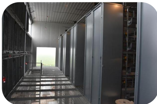
Les convoyeurs à fiente horizontal et vertical fonctionnent ensemble pour transporter la fiente de poulet à l'extérieur du poulailler.
