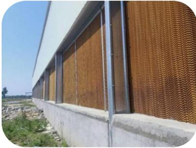
Avec des panneaux de rafraîchissement, l'air frais est refroidi, puis est envoyé au poulailler pour fournir de l'air humide aux poulets.
